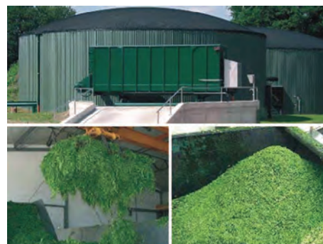
Рис. 10. Шатровий метантенк для перероблення трави (завантаження подрібненою травою здійснюється шнековим дозувальним пристроєм; бродіння триває протягом декількох місяців)
