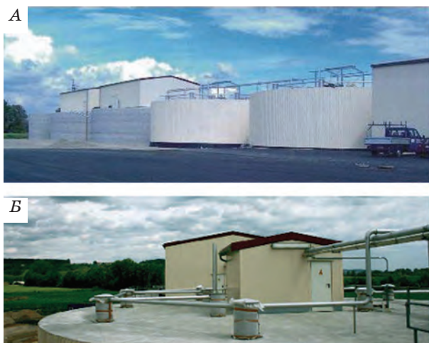
Рис. 11. Потужна біогазова установка фірми Zorg для цукрових заводів (А) і установка з перероблення пташиного посліду із заглибленим біореактором (Б)
