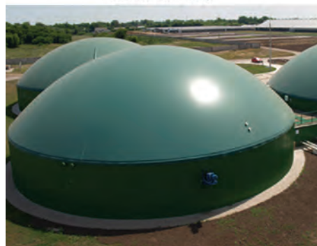
Метантенк Zorg шатрового типу в комплексі з газгольдером
