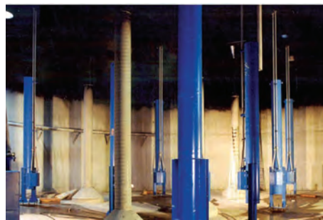
Рис. 19. Перемішувальні пристрої Cannon® Mixer усередині ферментера
