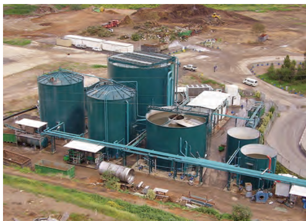
Рис. 14. Будівництво двоступеневої установки з виробництва біогазу поблизу Тель-Авіва (2005 рік)
