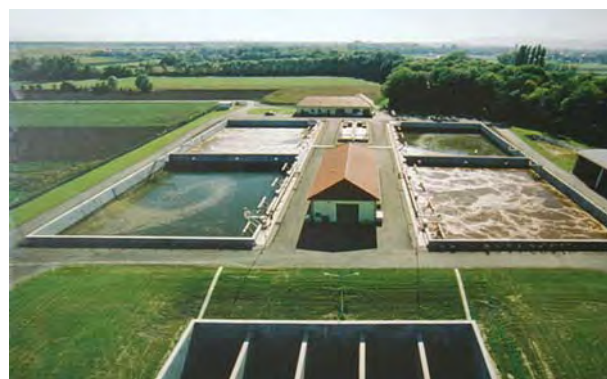
Рис. 16. Двореакторна SBR-очищувальна станція фірми Hydromatic GmbH
