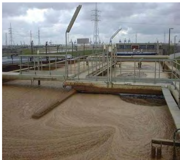
Рис. 15. Біореактор SBR
