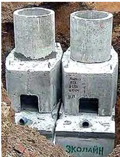
Рис. 1. Примітивний залізобетонний септик
