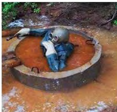
Рис. 1. Примітивний залізобетонний септик
